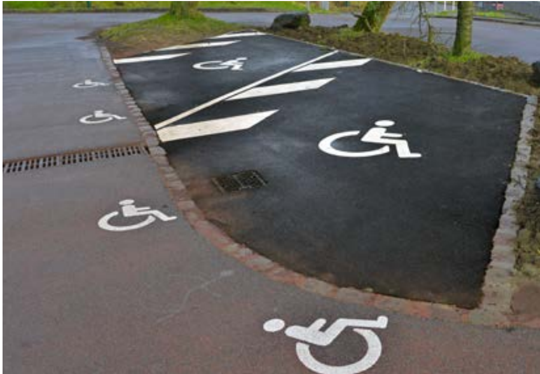
▲ Places de stationnement PMR sur le parking haut du LaM à Villeneuve d'Ascq
