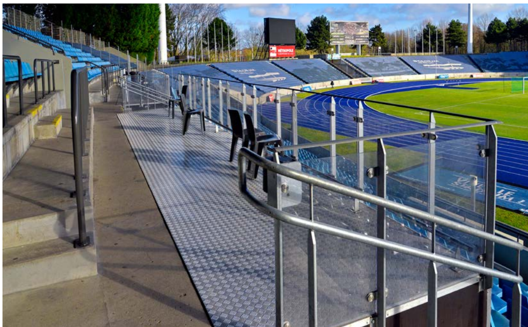
▲ Mise en place d'équipements adaptés - Stadium à Villeneuve d'Ascq
