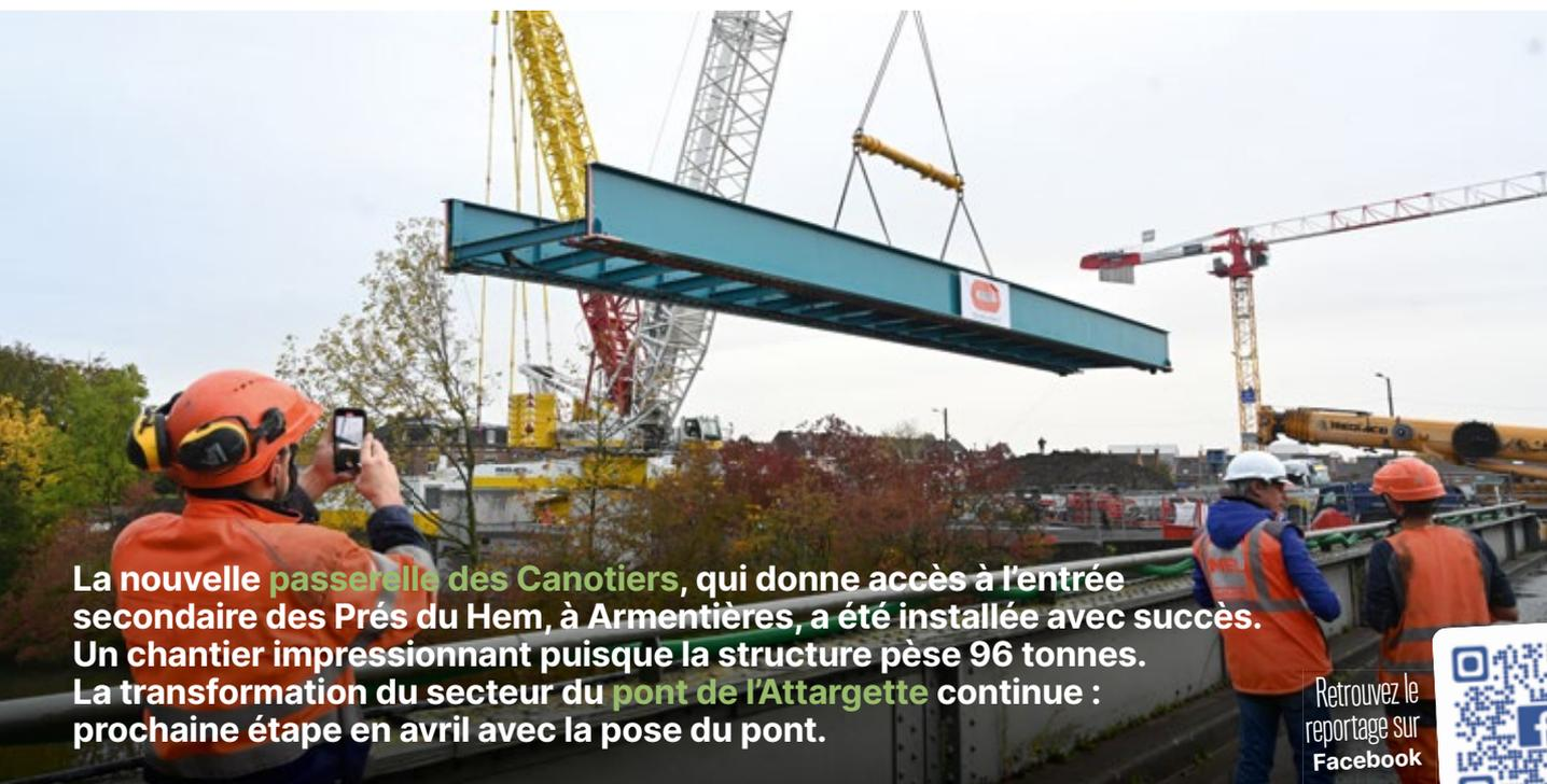
La nouvelle passerelle des Canotiers, qui donne accès à l'entrée secondaire des Prés du Hem, à Armentières, a été installée avec succès. Un chantier impressionnant puisque la structure pèse 96 tonnes. La transformation du secteur du pont de l'Attargette continue : prochaine étape en avril avec la pose du pont.
